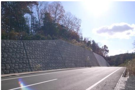
石積を模した擁壁の例（水口地区）
