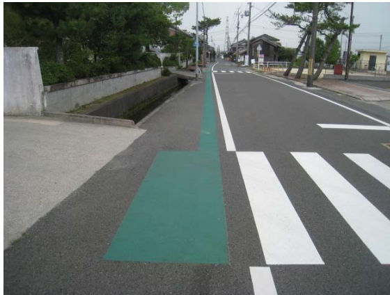
グリーンベルト施行写真
