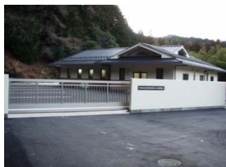
朝宮地区農業集落排水処理施設
