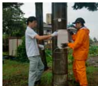
▲除去作業の様子
