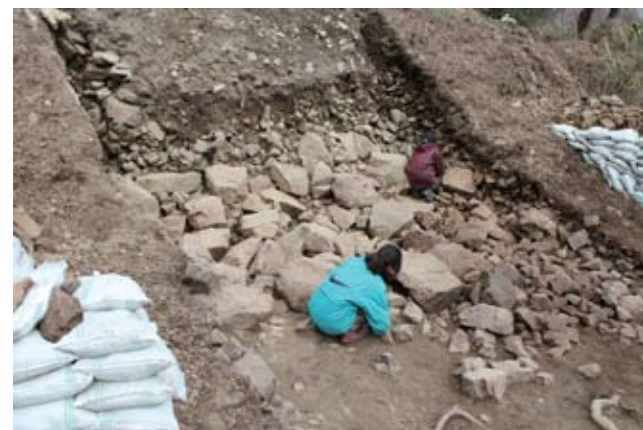
▲破城によって崩された石垣
