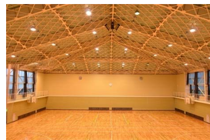
甲賀中央公園体育館の耐震補強
