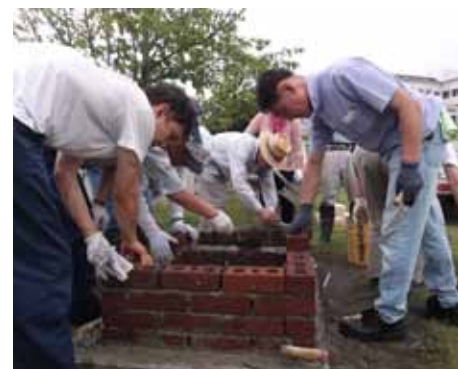
▲丁寧にレンガを積む作業(城山中学校)
