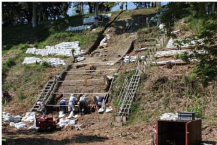
1トレ 南東から撮影
