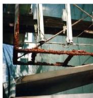
袖看板の底部脱落
