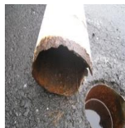
ポール看板の倒壊
