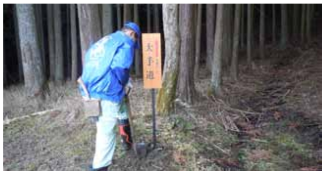
▲案内看板設置作業の様子
