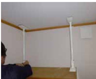
▲ポール式家具転倒防止用品を設置する様子
