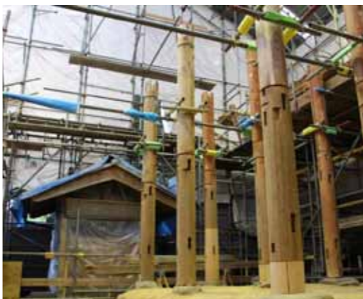
檜尾神社修理の様子
