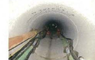
（トンネル内部の様子）
