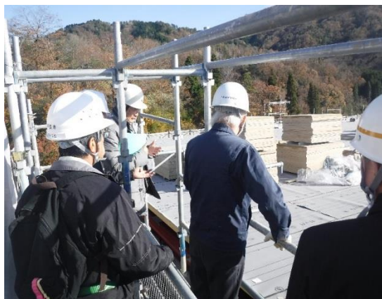
信楽体育館の工事技術監査
