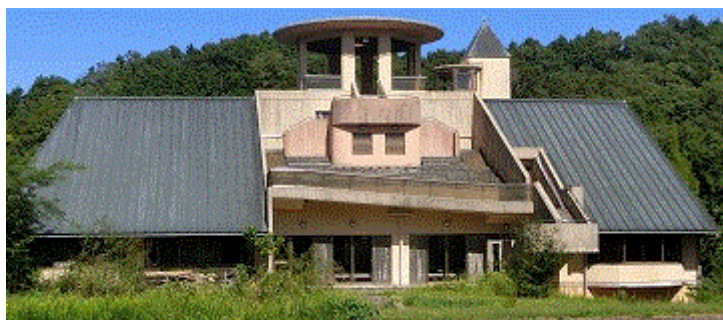
屋根の塗装がはげている部分がある
