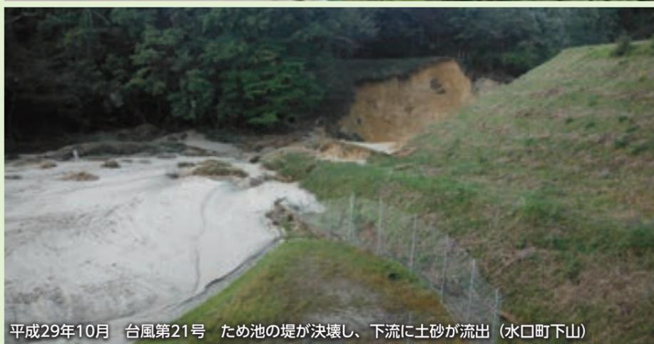
平成29年10月 台風第21号 ため池の堤が決壊し、下流に土砂が流出（水口町下山）
