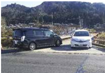
国道307号に面する勅旨西恩寺橋
