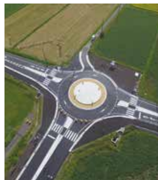
日野町に設置されたロータリー交差点
