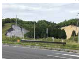
水口町新城地先で開発中の発電施設
