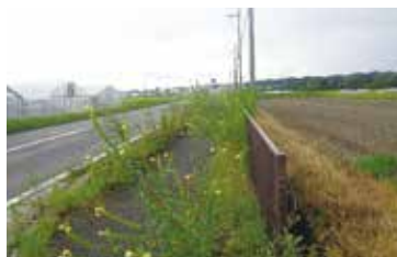
県道泉水口線の歩道
