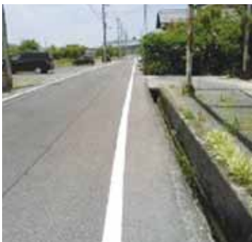
側溝蓋掛け、グリーンベルトの設置で通学路の安全確保を
