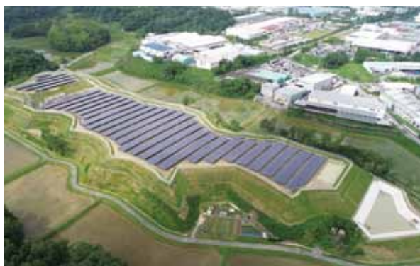
市内の太陽光発電所パネル設置面が全面貯水池になっている
