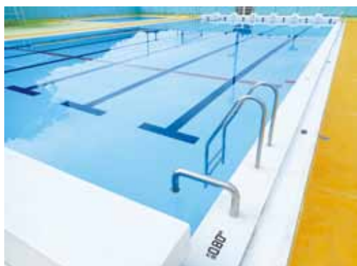
市内の学校プール
