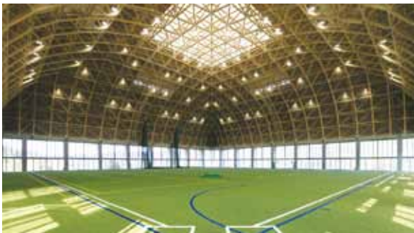
全天候型 間伐材活用ドーム（高知県立室戸広域公園アリーナ）
