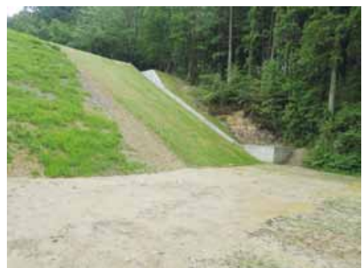
災害復旧工事が完了した永谷池
