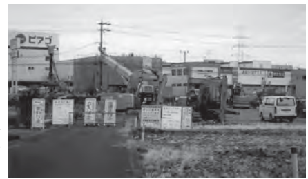
アンダーパス工事現場
