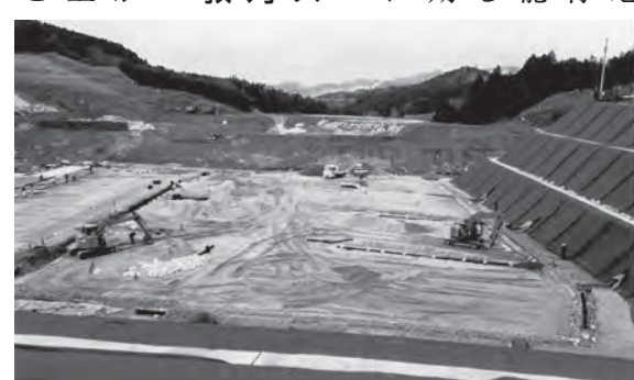
二期工事が進む クリーンセンター滋賀
