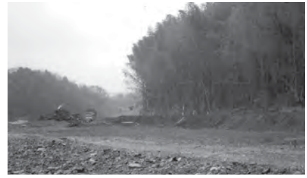
野洲川 総合流域防災事業工事現場
