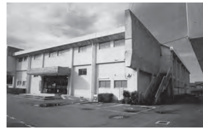
整備を要する水口体育館
