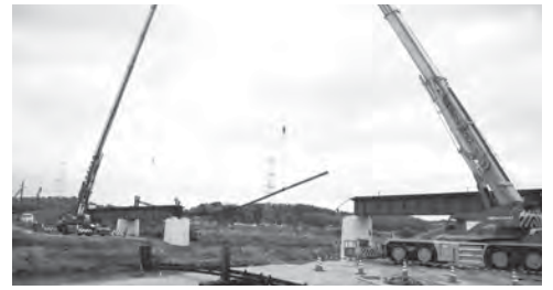
開始された復旧工事
