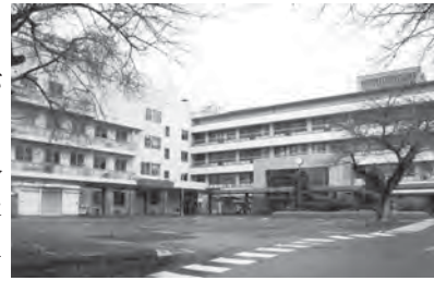
解体が待たれる旧甲賀病院
