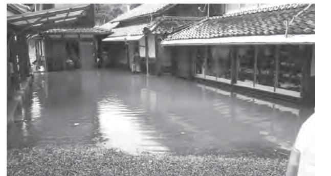
台風18号で浸水の葛上川隣接の民家
