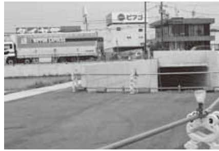
建設途中の地下道
