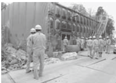
虫生野配水池築造工事
