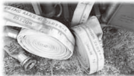
調べてみると製造から40年近く経過したホースもあった
