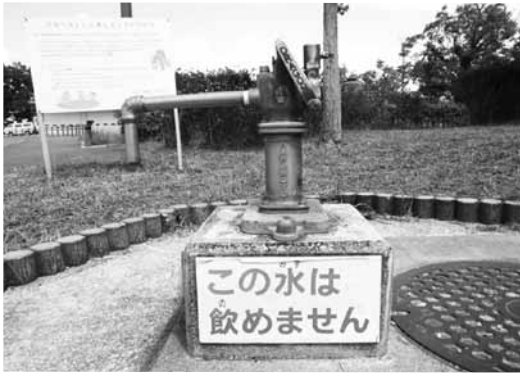
水口スポーツの森にある防災井戸
