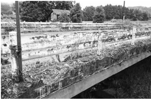
一刻も早く改修が待たれる「長谷橋」(甲賀町地先)
