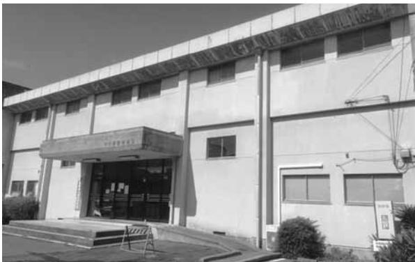
建替えが待たれる、現水口体育館
