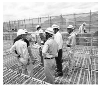
修繕中の信楽体育館の視察様子
