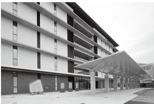
完成した新庁舎
