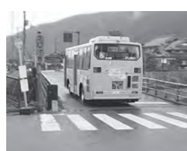
橋の塗り替えと歩道橋の設置が待たれる青木ガ瀬橋
