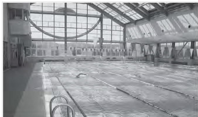
信楽中学校の室内プール
