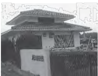
農業集落排水処理施設
