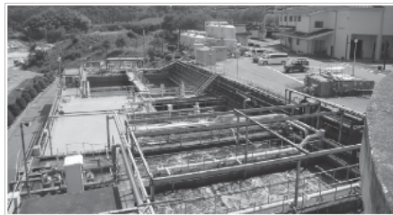
水処理施設整備工事予定地
