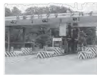
無料開放後の安全対策が望まれる
