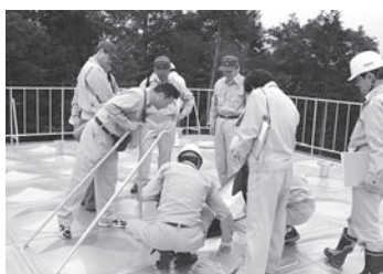
完成した牧上水施設
