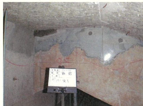
【着工後 教室天井梁】
