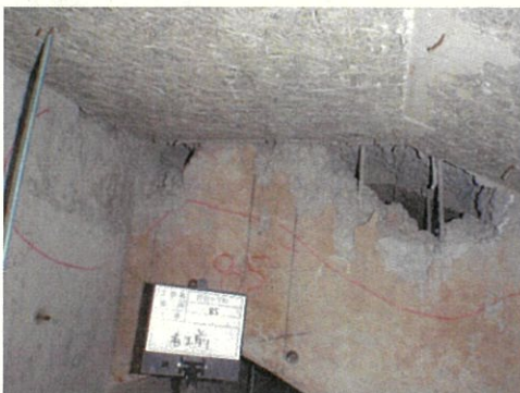
【着工前 教室天井梁】
