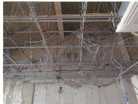
【着工後 教室壁】
