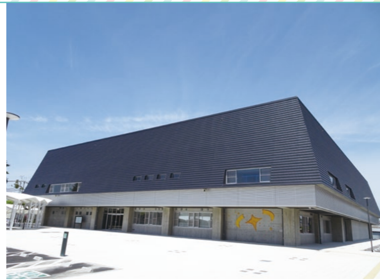
▲水口体育館 外観
