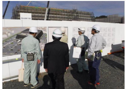
水口体育館新築の工事技術監査
