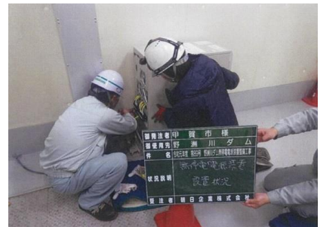
無停電電源装置整備工事 (設置作業)
