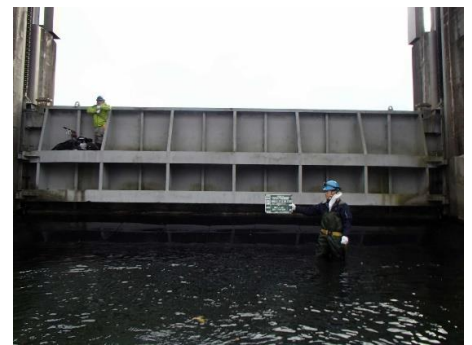
水口頭首工ゲート点検業務委託
