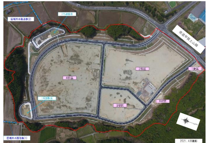
造成状況 (令和3年4月撮影)
