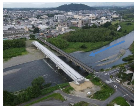
市道新町・貴生川幹線内貴橋 現況写真(R3.7時点)
