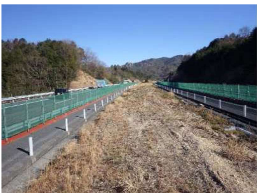
② 大津 JCT (仮称) 東側から名古屋方面を望む 工事着手前写真
