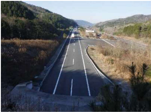
① 甲南トンネル西側から大阪方面を望む 工事着手前写真
