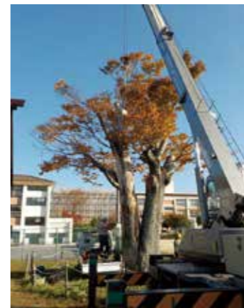
クレーンに吊り上げられ伐採されるケヤキ
