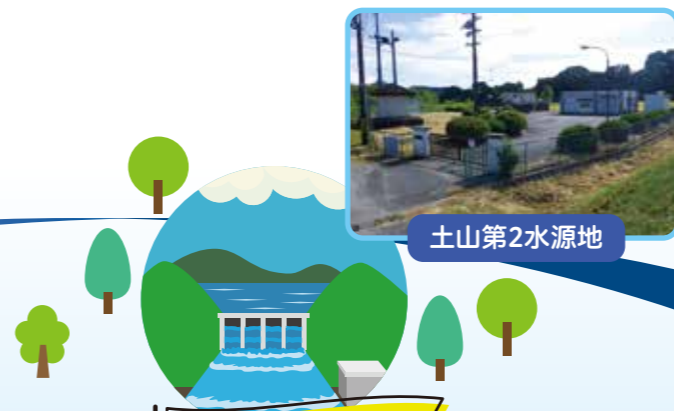
取水場(水源地)
