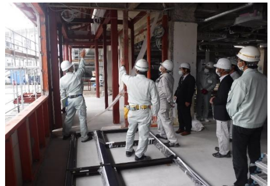
水口社会福祉センター改修工事
