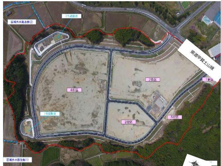
（仮称）甲賀北地区工業団地（新名神甲賀工業団地） 造成状況（令和3年4月撮影）
