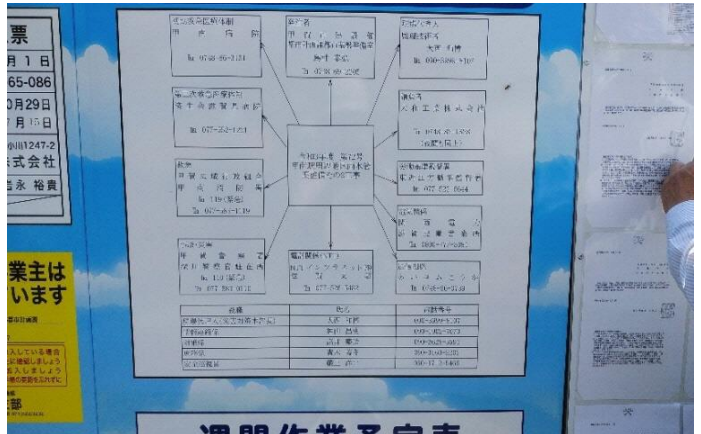
写真－7 工事標示板設置状況 (緊急連絡網)
