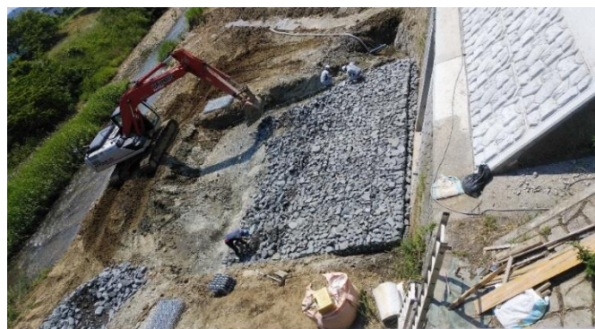
写真-4 工事現場施工状況 吐口工 カゴマット施工
