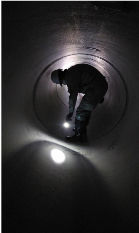
写真－5 工事現場施工状況 管推進工 φ1350mm
