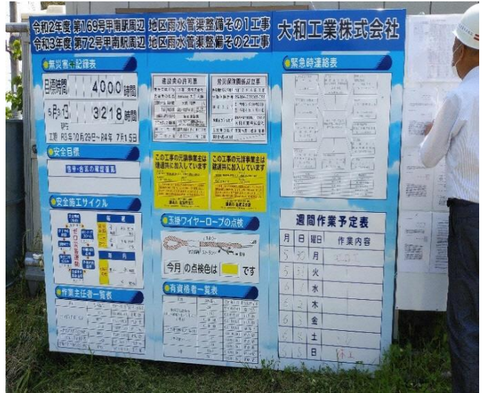
写真－6 工事標示板設置状況
