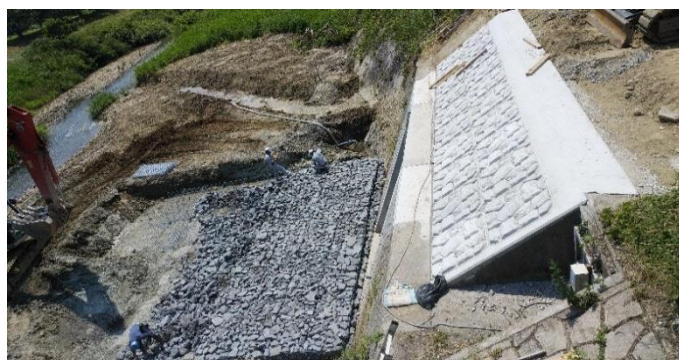
写真-3 工事現場施工状況 吐口工 護岸復旧工
