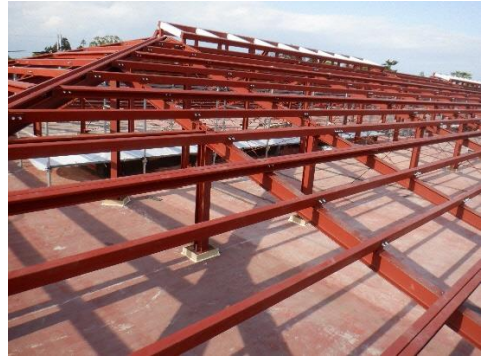
屋根鉄骨、ベースのグラウト作業完了
