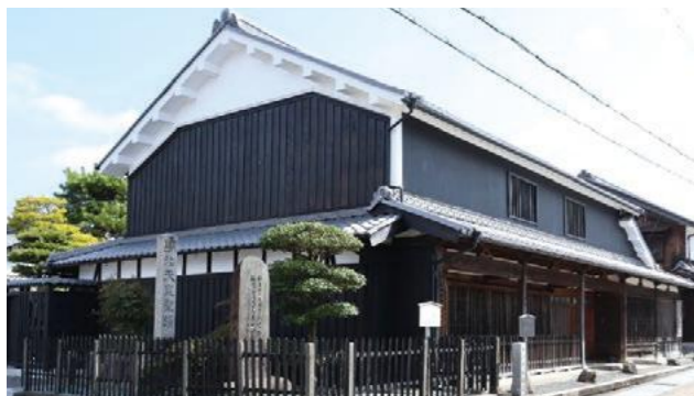
▲土山家住宅(土山宿本陣跡)主屋外観
