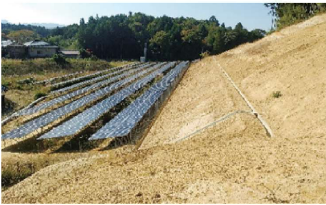
復旧が進む土砂災害の現場
