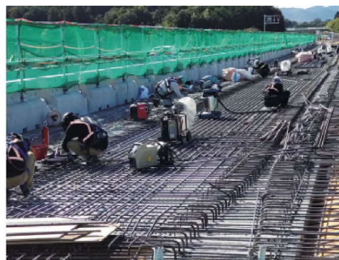
工事が進む6車線化工事（佐治川橋）
