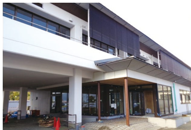
完成間近の水口社会福祉センター▲
