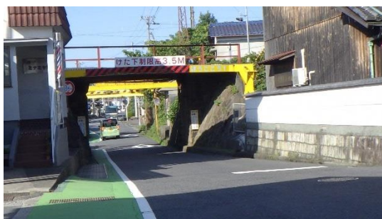
■ 鉄道高架下の道路が狭く危険
