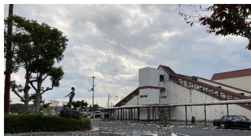
■ 送迎時に、駅北口ロータリー及び周辺道路が混雑
