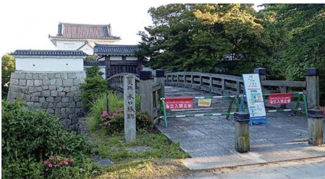
通行止が続く水口城跡の「御成橋」
