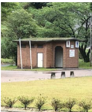
青土ダム駐車場(展望公園)トイレ
