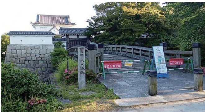
通行止が続く水口城跡の「御成橋」
