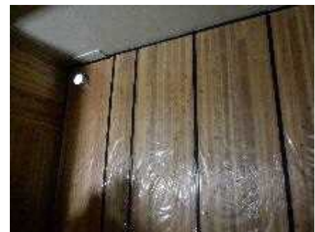
CLT 壁構造体
