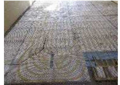
床暖房設備工事
