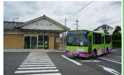
待合所を整備した近江土山駅
