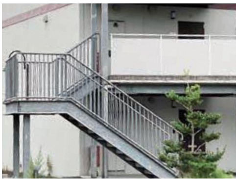
大原中市営住宅
