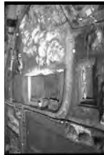
外郭南西角・大垣基礎の石垣
