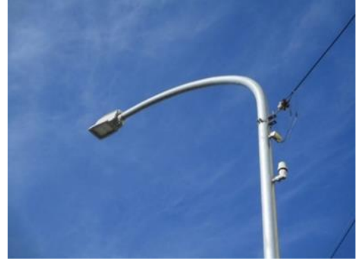
防犯灯：水口町水口
