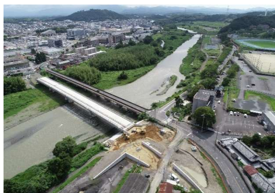
市道新町・貴生川幹線内貴橋 現況写真(R4.7時点) (下(左岸)水口町北内貴、上(右岸)水口町水口)
