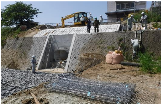
甲南駅周辺地区雨水管渠整備その2工事
