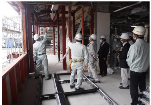
水口社会福祉センター改修工事
